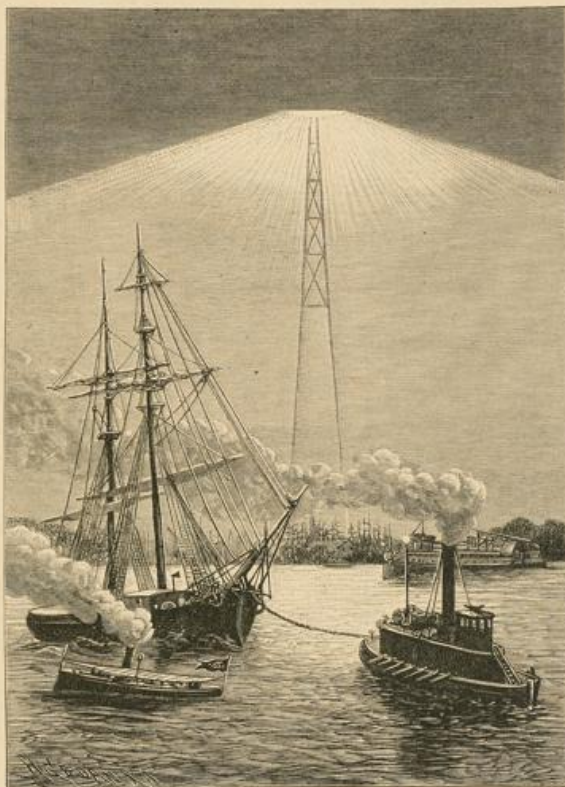
Der elektrische Leuchtturm am „Höllenthor“ bei New-York.
