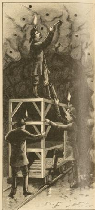
Das Laden der Bohrlöcher.
