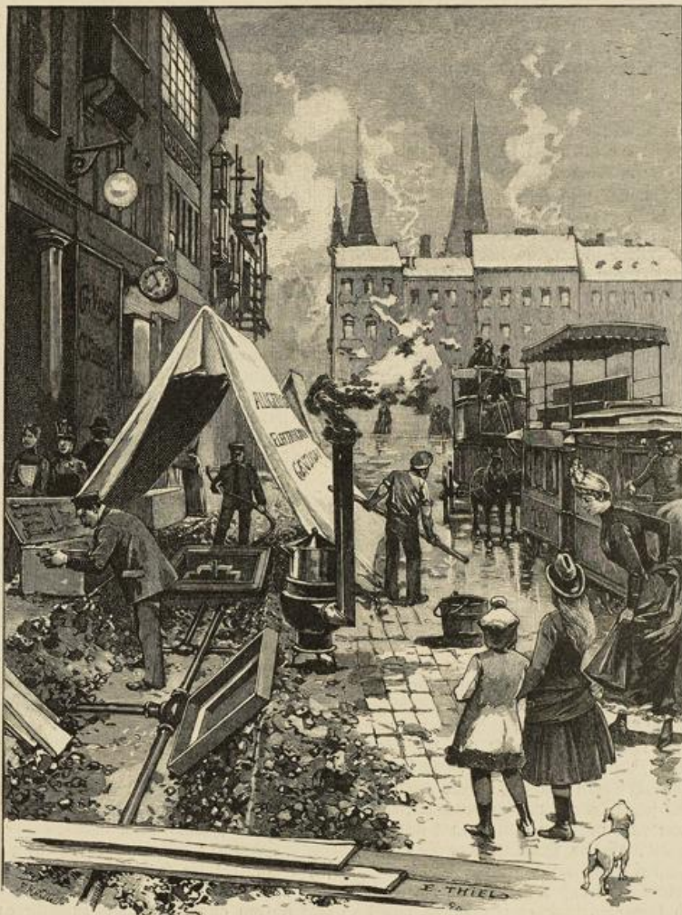
Kabellegung in einer Straße Berlins.
