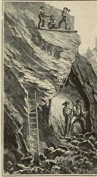
Herstellung des Bohrloches für die Sprengminen.
