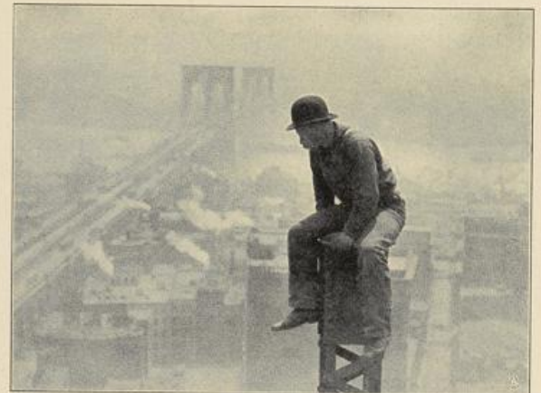
Arbeiter auf dem Bau.
