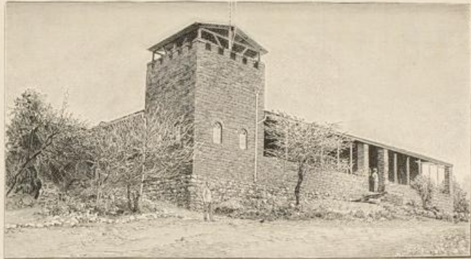
Blick aus Südwestafrika: Wohnhaus des Landeshauptmanns Major Dautzin in Windhof.
