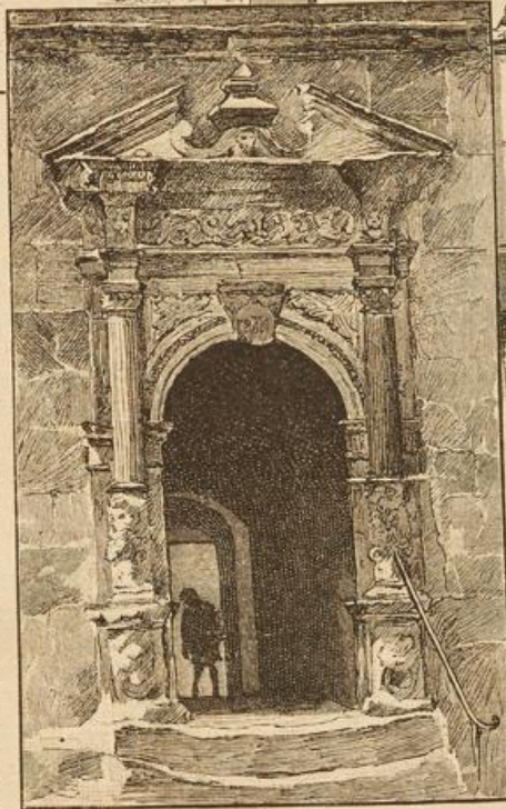
Portal am sogen. Kanzlei-Gebäude.
