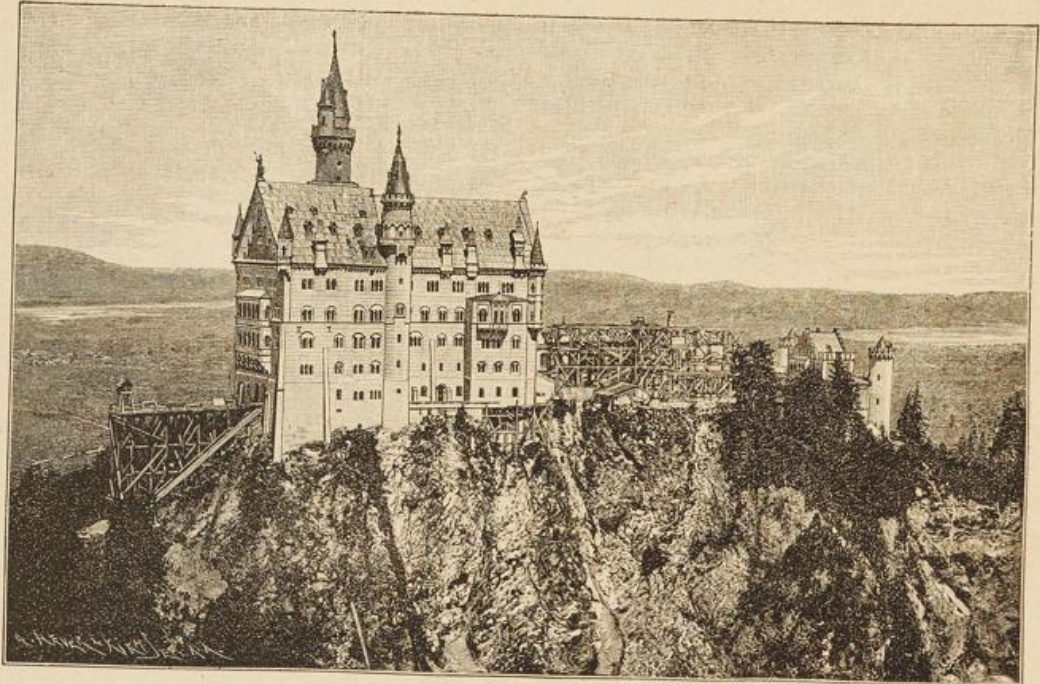
Schloß Schwannstein, im Bau unvollendet. Rechts unten die Burg Hohen Schwangau.
