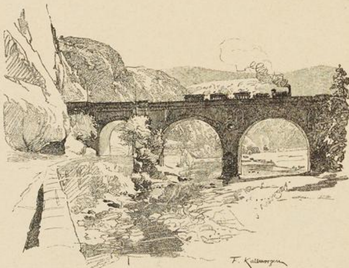
Eisenbahnbrücke bei Oberstein.
