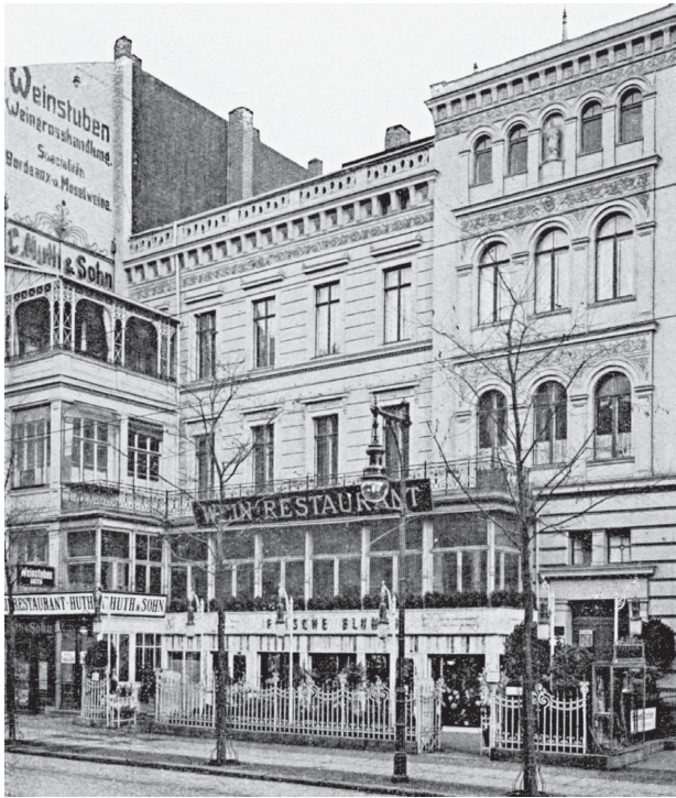
Weinhaus Huth, Potsdamer Straße 139, fast am Potsdamer Platz. Justizrat Robert bewohnte die Etage direkt über dem Restaurant, in dem sich auch Fontane gelegentlich einfand. In Effi Briest lässt er Innstetten hier verkehren. Das Haus wurde 1912 abgerissen und durch den noch heute vorhandenen Bau ersetzt.
