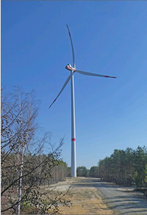
Abb. 2: Im Sommer 2019 errichtete Windenergieanlage des Typs „Vestas V136“ im Windpark bei Spremberg, März 2020.
