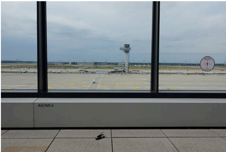
©C.Wegworth Unter den Vordächern des Haupteingangs und der Besucherterrasse nisten zahlreiche Mehlschwalben. Die unmarkierten Glasflächen werden dort für viele von ihnen zum Verhängnis.
