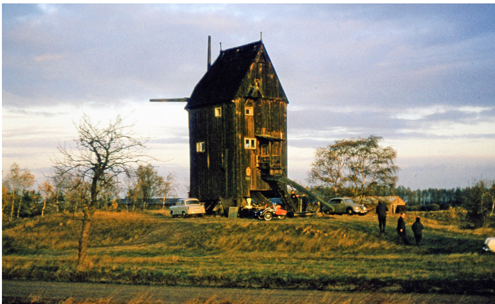
Abb. 49: Die alte Bockwindmühle bei Prietzen am Gülper See – 1961 von der Pädagogischen Hochschule Potsdam erworben und für Feldarbeiten genutzt. Foto: H. Schreiber (1971).
